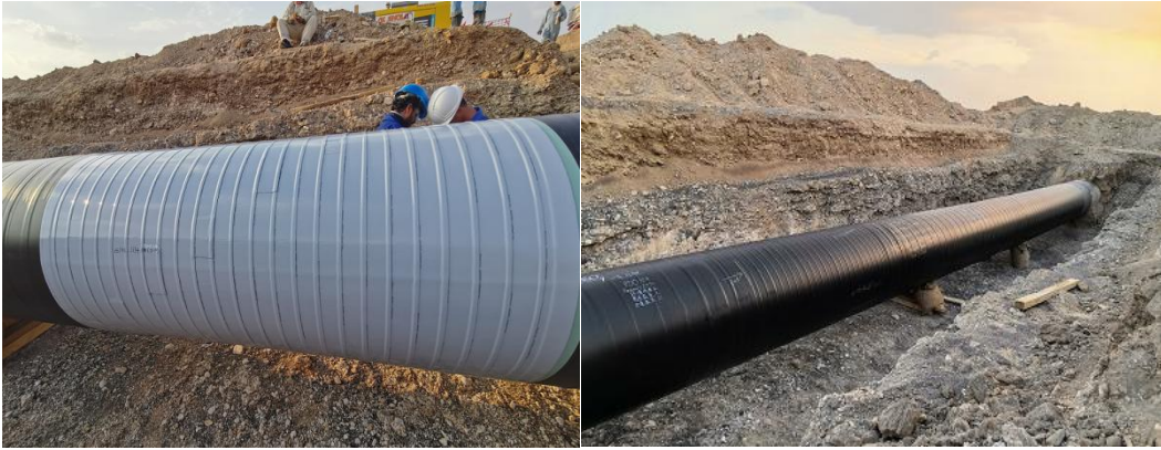
2) 埋地管道焊缝补口
